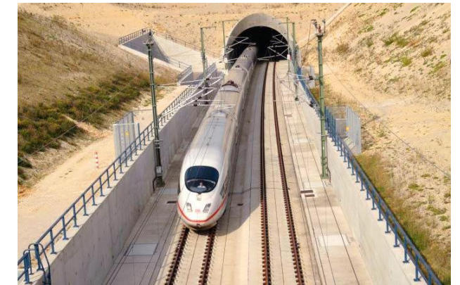
Abb. 28: ICE Neubaustrecke Nürnberg – Ingolstadt (Tunnelbauwerk)
